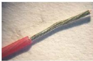
Рис.2 Подготовка кабеля
